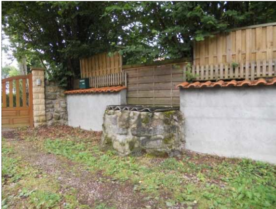
Puits rond en pierres jointées, ouverture horizontale recouverte par une tôle
