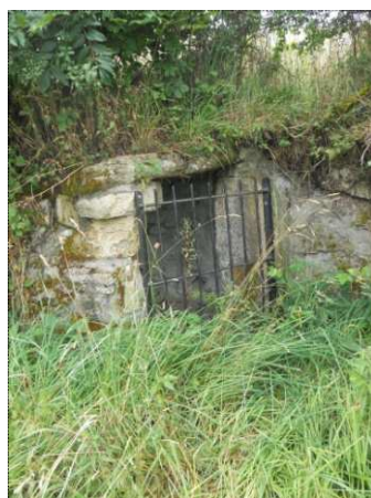
Puits en pierres sèches ; fixer la porte correctement, vérifier la maçonnerie
