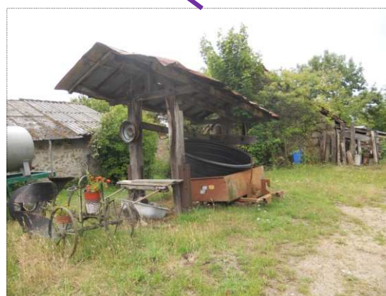
Entrave avec une structure en bois et un toit en tôles ; rénover l'ossature bois, refaire la toiture
