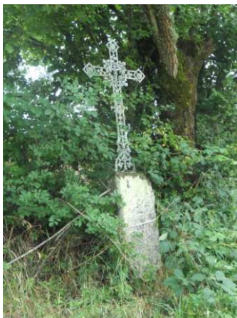
Croix en métal, posée sur soubassement en béton ; débroussailler les abords, vérifier fixation
