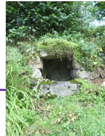
Puits construit en pierres sèches ; doit être débroussailler, vérifier la maçonnerie pour sauvegarde
