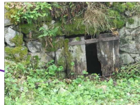
Puits encastré dans un muret, avec encadrement en pierres de taille, toujours utilisé ; refaire une poste pour sécuriser, puis veiller au maintien du muret
