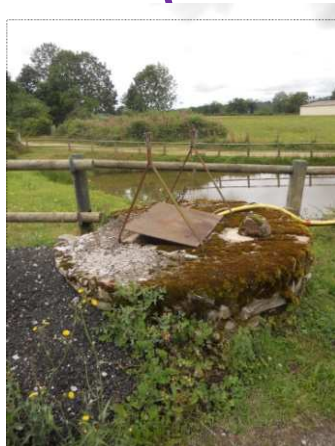
Puits rond avec ouverture horizontale encore utilisé ; nettoyer les mousses, rénover le mécanisme
