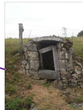
Puits en pierres ; consolider la maçonnerie et refaire une porte neuve
