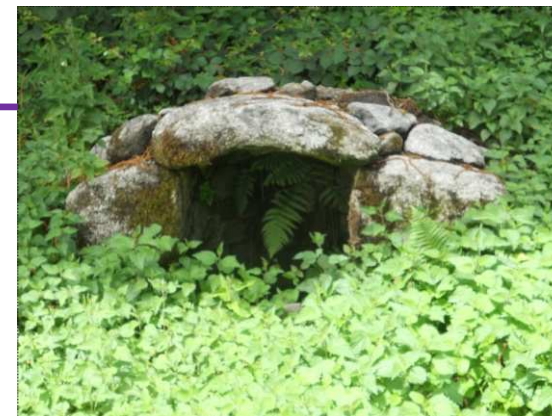
Puits construit en pierres, avec grande ouverture; nettoyer la végétation, ensuite la mousse, sécuriser l'élément en installant une porte
