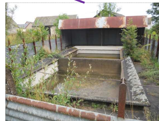
Lavoirs rectangulaires de très grande taille ; supprimer l'enclos en tôle et revoir le toit, entretenir les abords
